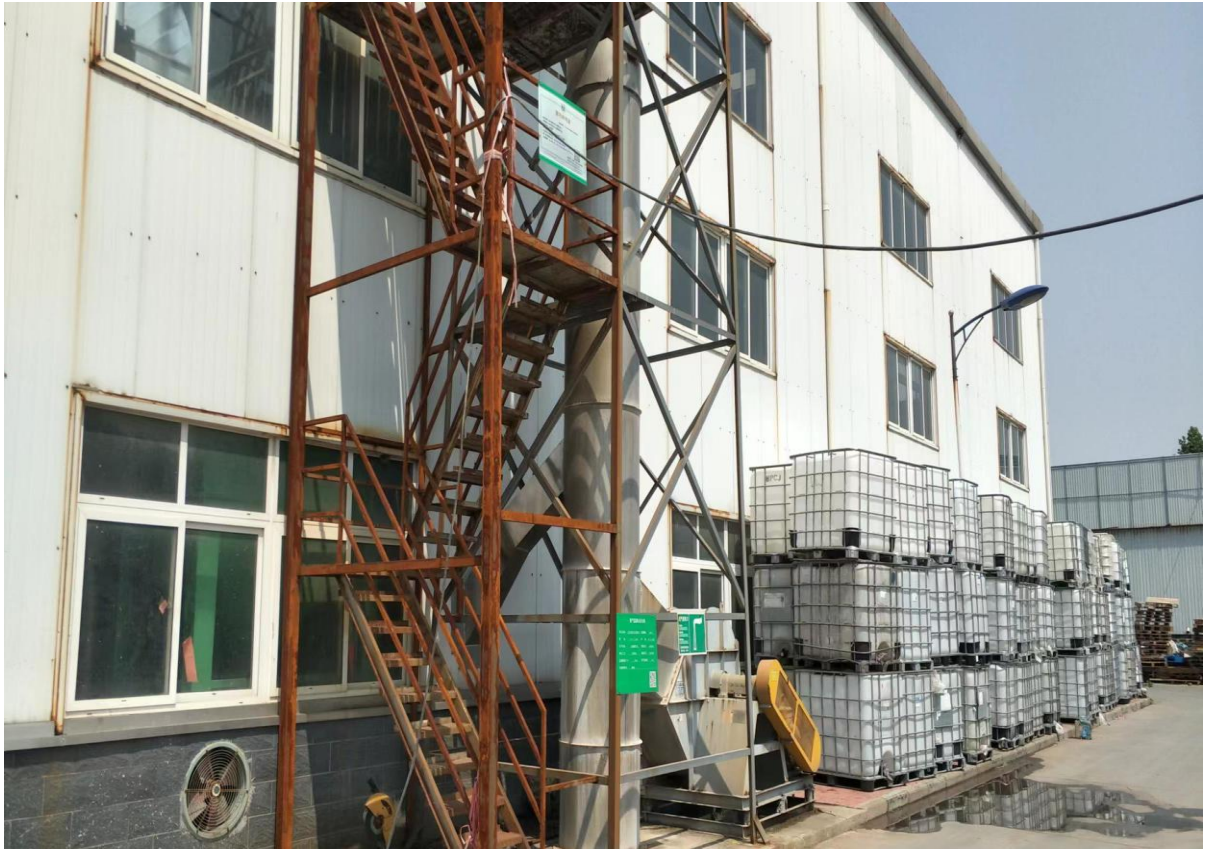
图 4-3 依托环境友好型涂料一车间现有 25m 高排气筒及排放标志
