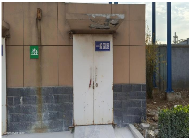
一般固废暂存库
