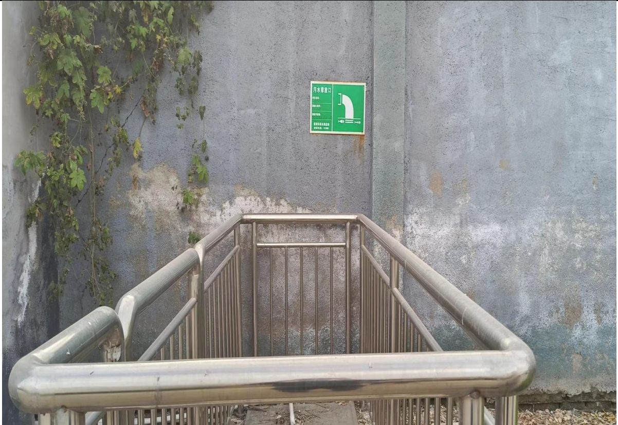
图 6-3 巴德士现有厂区污水处理站总排口
