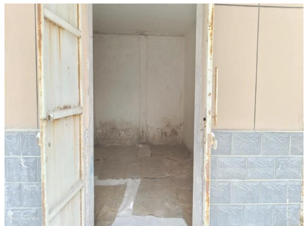
一般固废暂存库
